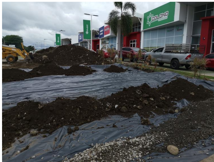
Campo de infiltración Coquito Plaza
