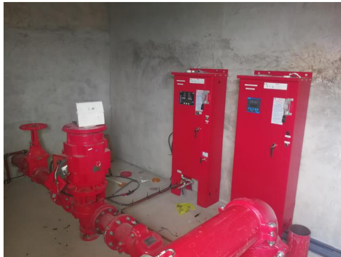
Suministro e instalación de bomba 500 gpm, transfer y controladores de SCI edificio Mall Frontera
