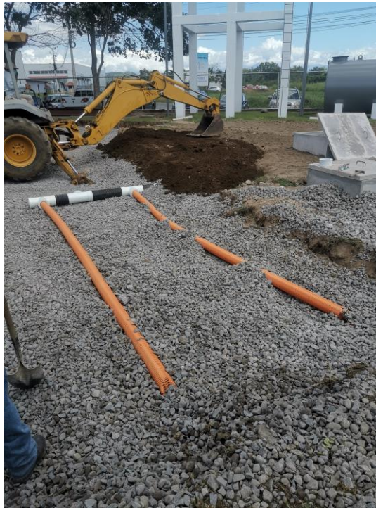
Campo de infiltración Coquito Fase I
