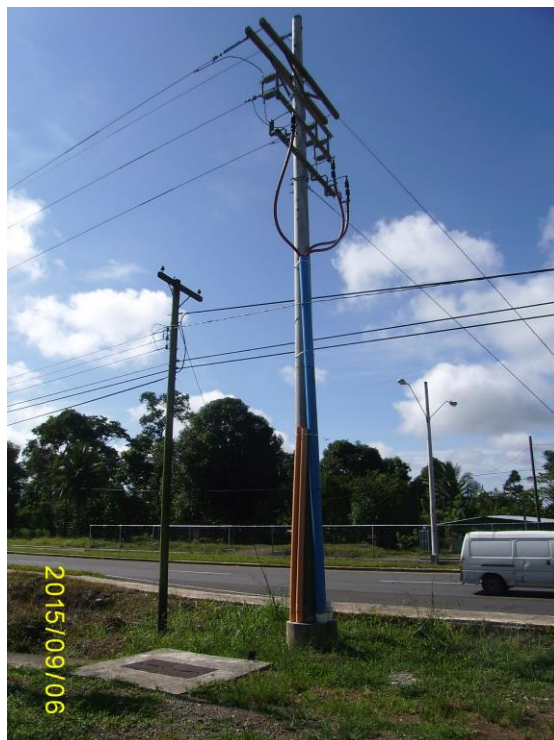
Paso aéreo subterráneo Gariche frente e centro de Salud.
