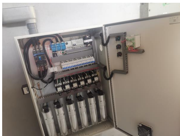
Banco de capacitores automático parte interior
