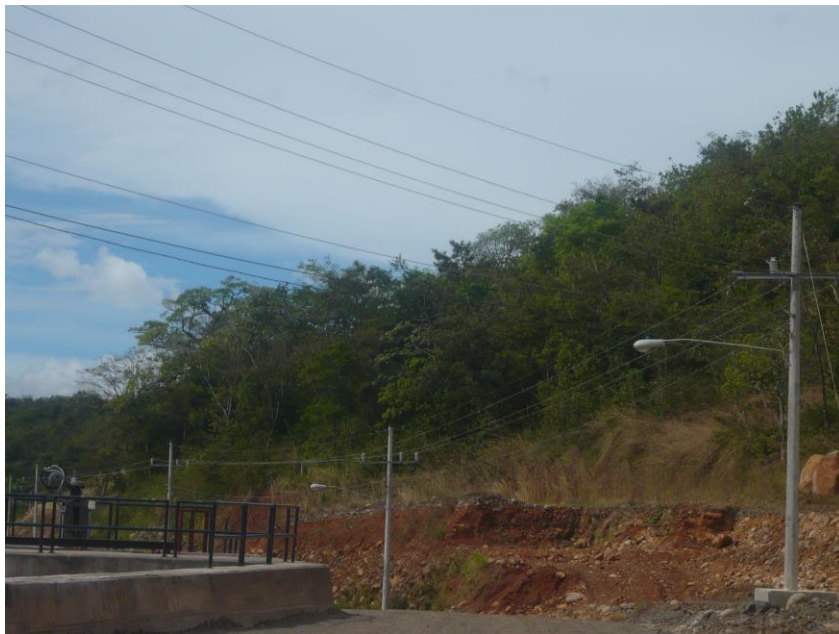
Suministro e instalación de tendido eléctrico, en 34.5 kv 1/0 Al Para alimentación eléctrica de embalse Hidroeléctrica Mendre en Caldera
