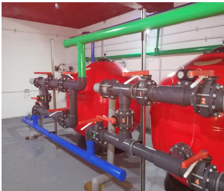
Instalación de filtraje para piscina olímpica de Universidad Nacional Campus Armodio Arias
