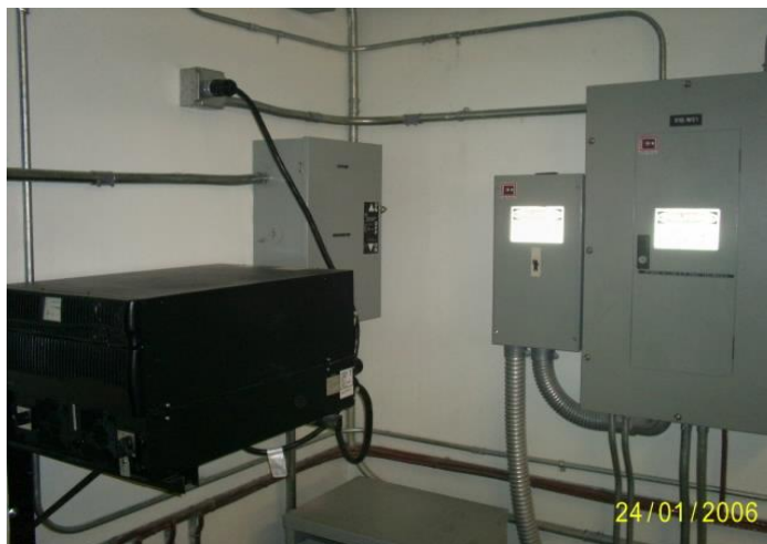
Foto de ups, transfer, y paneles instalados en AES PANAMA, en Gualaca
