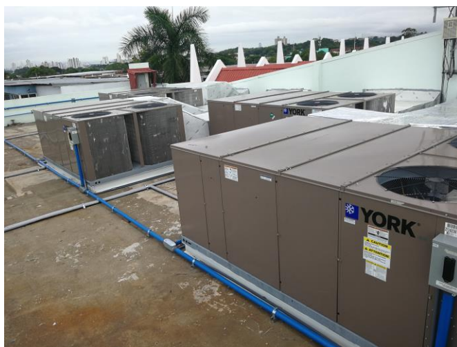
Instalación de unidades A/A autocontenidas de 20 ton c/u Iglesia SJ Tadeo
