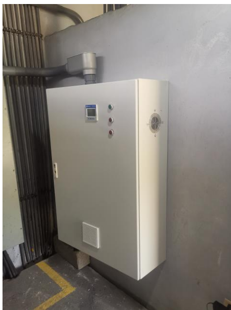
Banco de capacitores automático parte exterior
