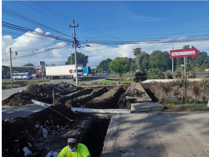
Campo de infiltración en plaza Coquito
