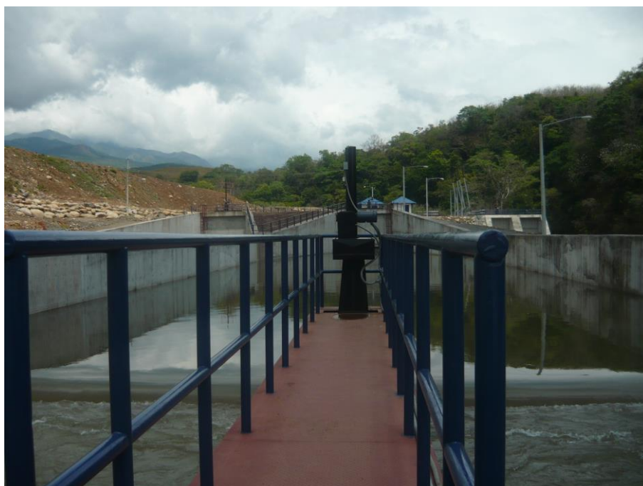
Construcción e instalación de operador de compuerta para desarenador
