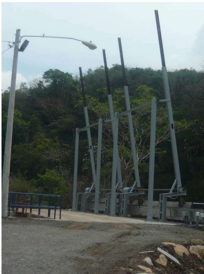
Instalación de Rejillas y rastrillo mecánico para hidroeléctrica de Mendre
