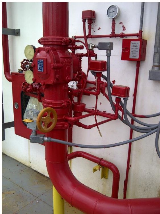
Válvula de Diluvio para SCI Central hidroeléctrica de Prudencia en David
