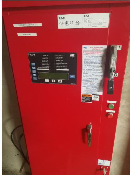
Suministro e instalación de bomba 500 gpm, transfer y controladores de SCI edificio Mall Frontera
