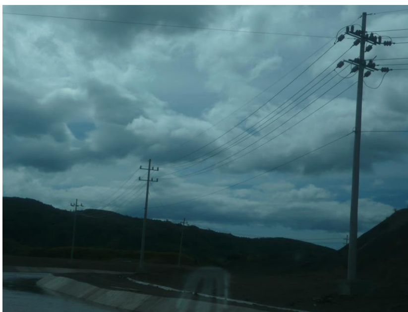
Suministro e instalación de Línea de transmisión con capacidad de 3 circuitos, en 34.5 kv 500mcm Al Para casa maquina a subestación de caldera
