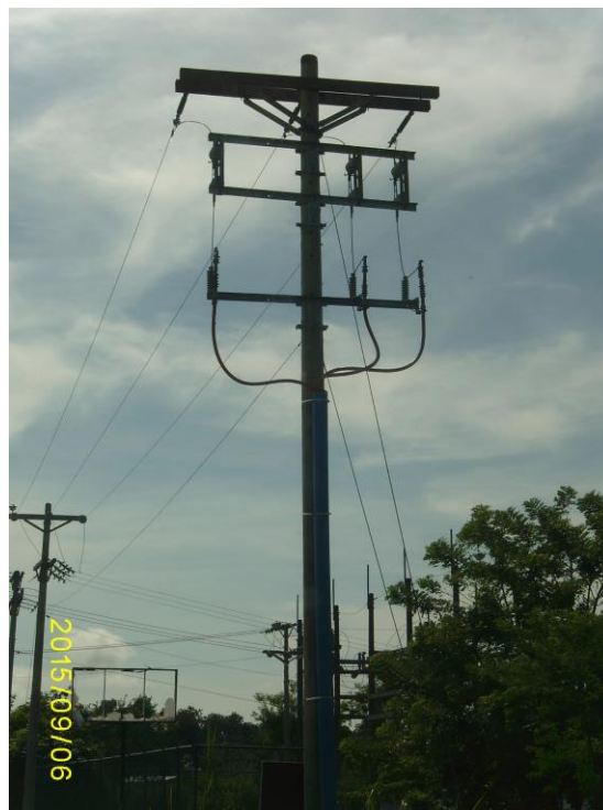
Paso aéreo subterráneo Bugaba estación EDECHISA.
