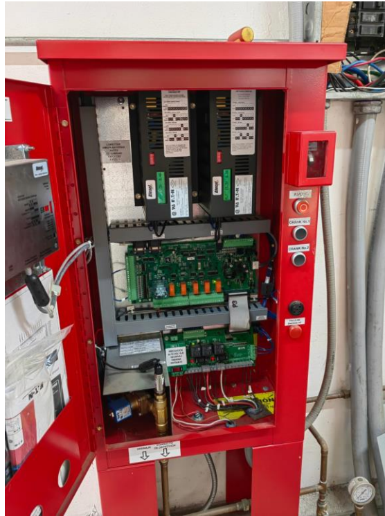
Mantenimiento PH Chiriqui Mall – controlador Diesel Clarke 750 gpm
