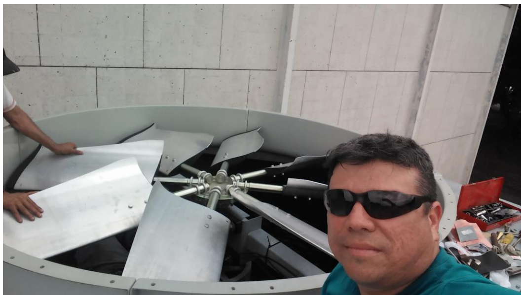
Alineación de Abanico de Torre de enfriamiento Universidad de Panamá
